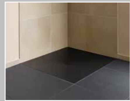
Tenslotte wordt de douchevloer in het frame geplaatst en de afvoergarnituur volledig aangesloten. De voegen worden elastisch verzegeld. Zo blijft de complete constructie duurzaam geschikt voor renovatie.
