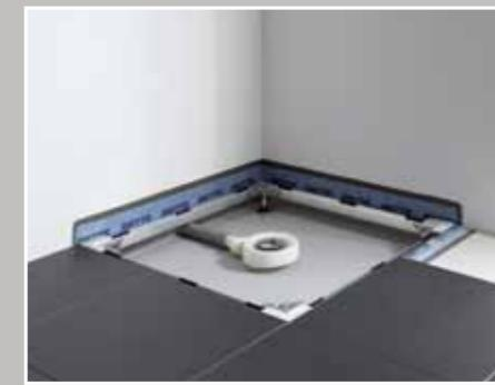
Nadat de dekvloer is gegoten, vindt de afdichting met het bouwlichaam plaats met behulp van het afdichtingsvlies en de PE-afdichtband. Aansluitend worden wand en vloer betegeld.
